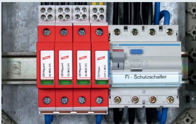
Пример последовательного включения УЗИП с использованием STAK 2X16 в соответствии с DIN VDE 0100-534.
