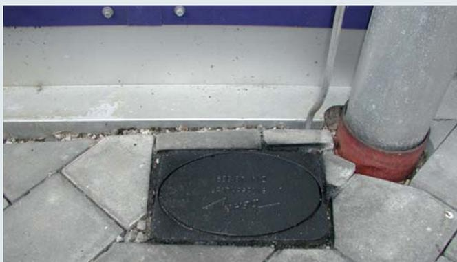
Инспекционные люки для подпольного монтажа, для отключения токоотводов от заземления при выполнении измерений.
