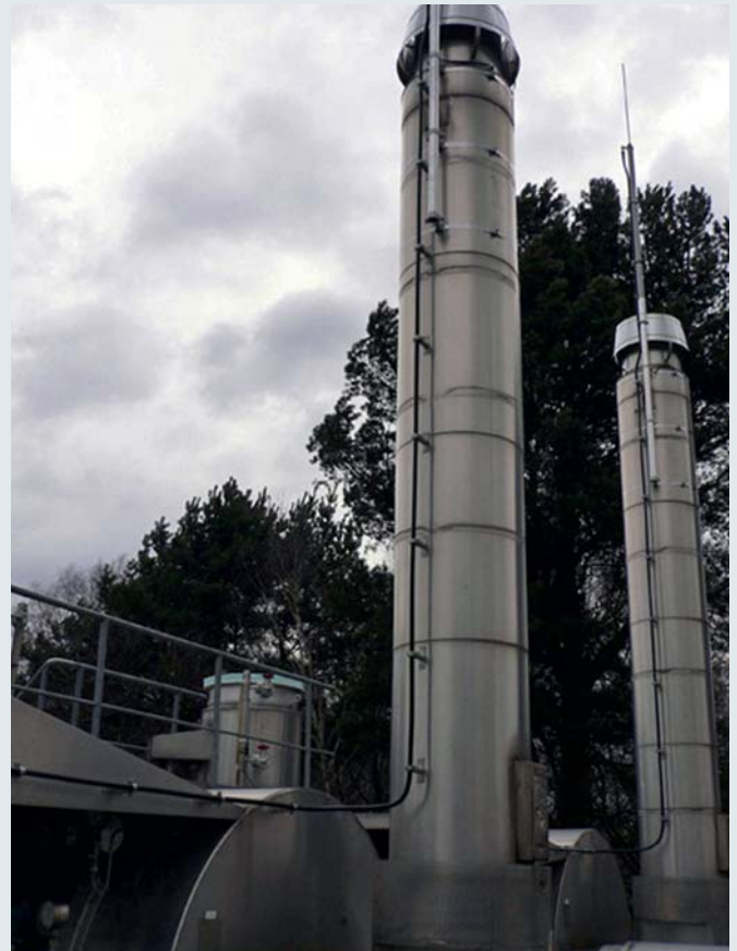
Прокладка токоотвода HVI в Ex-зоне 2
