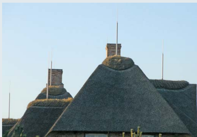
Рис. 4: Новое исполнение – Молниезащита на мягкой кровле (фрагмент)
