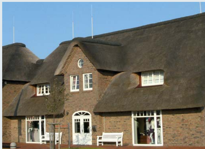
Рис. 1: Новое исполнение – молниезащита на мягкой кровле (общий вид)
