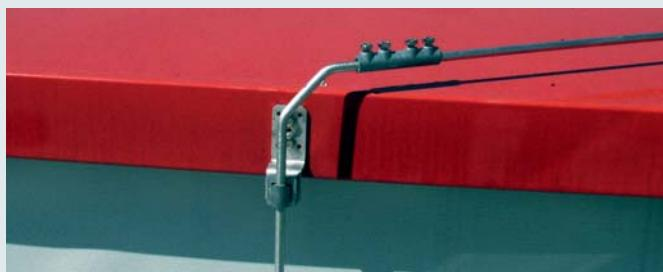
Соединительные муфты для параллельного соединения двух круглых проводников с четырьмя болтами М6
