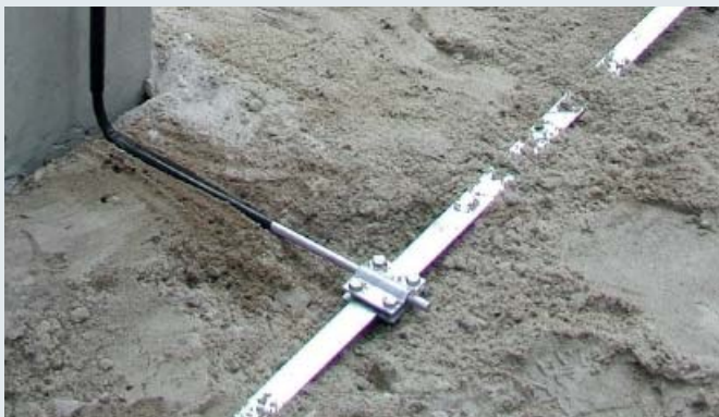
Крестообразные соединители для надземного и подземного монтажа для крестообразного и Т-образного соединения проводников
