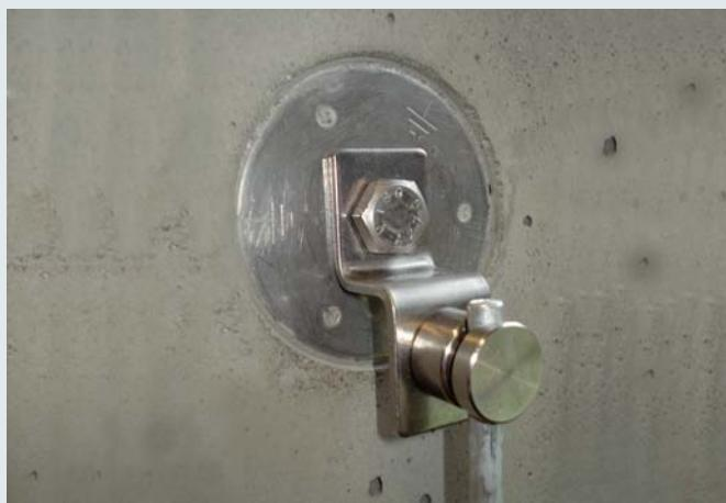
Наконечники для монтажа на фиксированные точки заземления для подключения, например, к шине уравнивания потенциалов или для присоединения частей конструкции (например, стальных балок и т.п.) с помощью болтов
