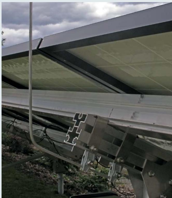
**Молниеприемник в комплекте с двумя фальцевыми клеммами
