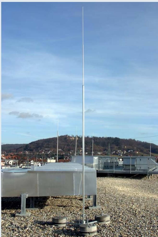
Отдельно стоящие молниеприемники со складной треногой для защиты массивных надстроек на крыше, с возможностью установки на кровлях с углом наклона до 10 градусов. Молниеприемники рассчитаны на применение в зонах со скоростью ветра до 145 км/ч (II зона ветровой нагрузки).
