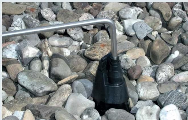
Кровельный проходной ввод для герметичного ввода токоотвода через кровлю
