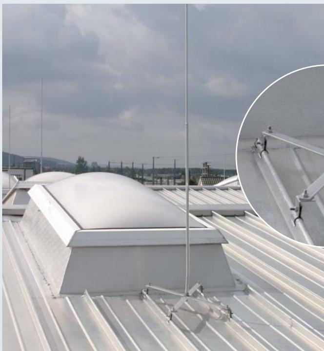
Молниеприемники для защиты сооружений на крыше, стеклянных куполов и т.п.
