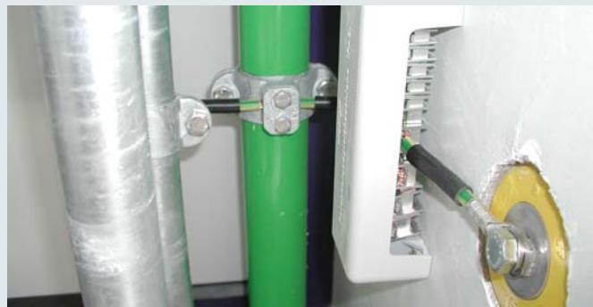
Шины уравнивания потенциалов для использования в качестве защитного и функционального уравнивания потенциалов согласно IEC 60364-4-41/60364-5-54 (DIN VDE 0100 часть 410/540) и молниезащитного уравнивания потенциалов согласно IEC/EN 62305-3.
