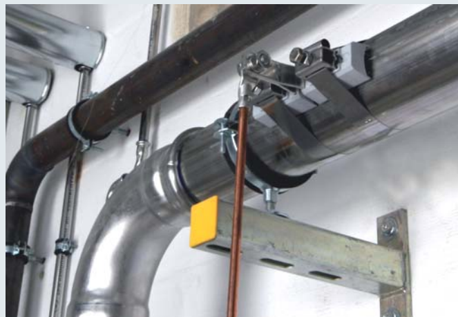
Монтаж на трубе из нержавеющей стали
