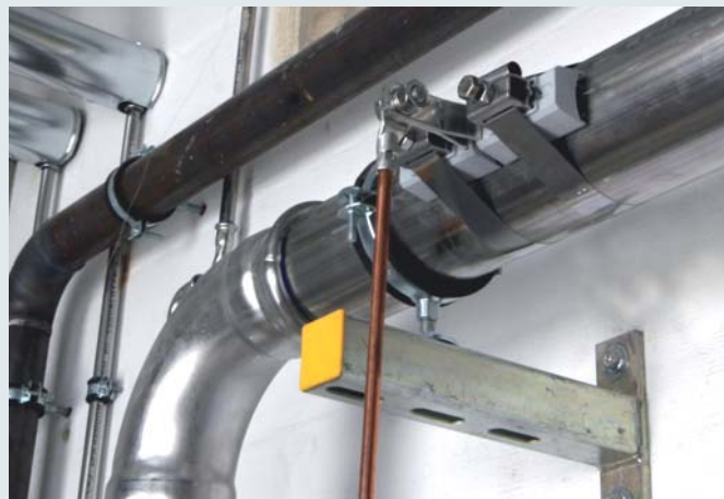
Монтаж на трубе из нержавеющей стали
