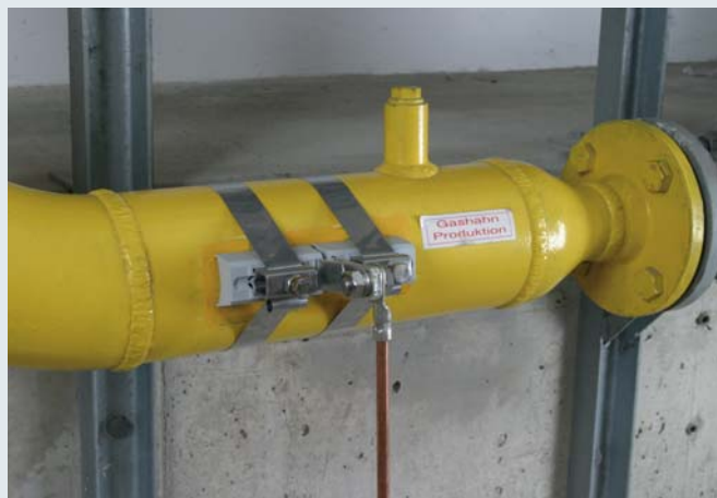
Ленточный хомут для включения труб во взрывоопасных зонах в систему молниезащитного уравнивания потенциалов согласно IEC 62305-3 (VDE 0185-305-3)
